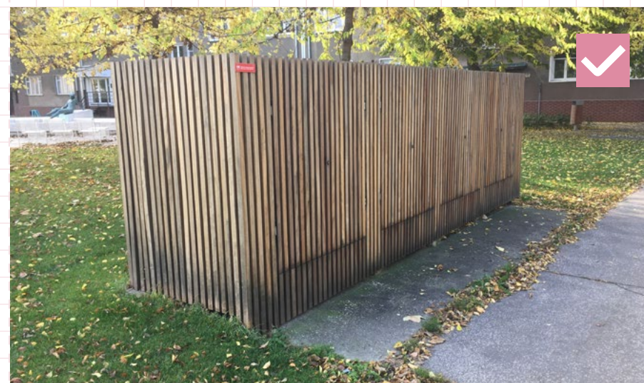
10 Vhodný príklad združovania existujúcich RIS pod spoločnú obalovú konštrukciu s ponechaným prístupom k technickému otvoru každej RIS. Záhradnícka ulica, Bratislava
