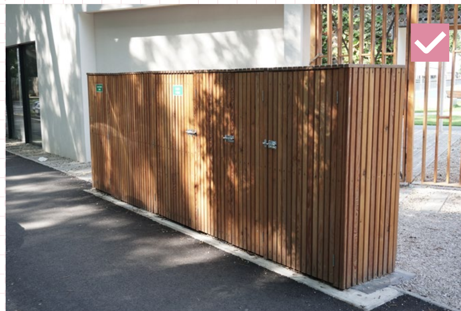
08 Vhodný príklad dizajnového riešenia dreveného plášťa integrovanej RIS. Zároveň by v uvedenom prípade bolo vhodnejšie umiestniť RIS dozadu na štrkový povrch. Bratislava, Park Jama
