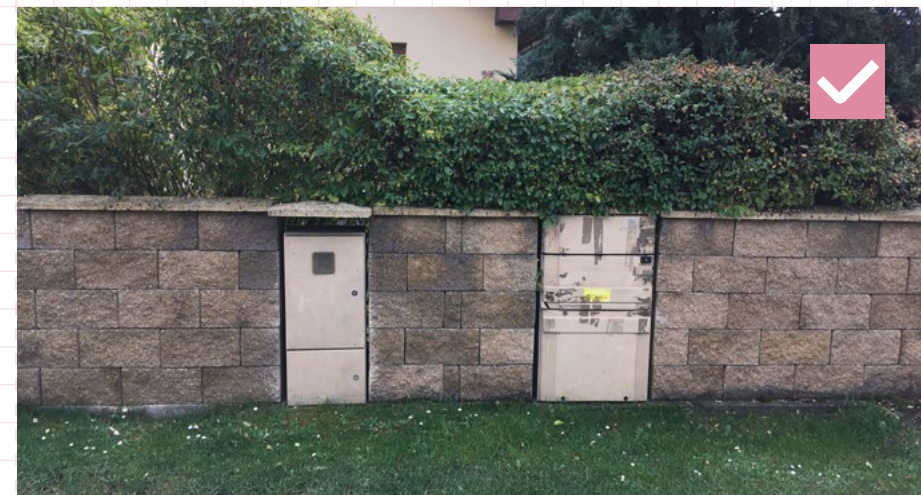
24 Vhodný príklad výškového zarovnania RIS s opločením, v ktorom je RIS integrovaná. Nemecká
