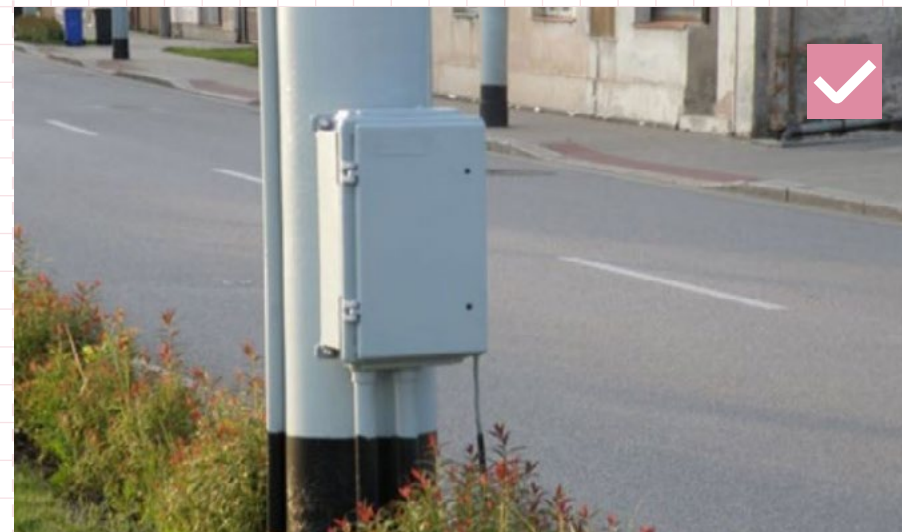
09 Vhodný príklad integrácie a farebného zjednotenia RIS so stĺpom trakčného vedenia. Bratislava
