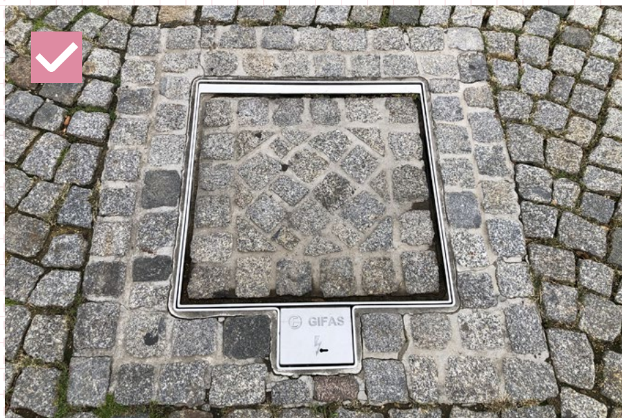
07 Vhodný príklad zjednotenia poklopu RIS s okolitou dlažbou. Dráždany
