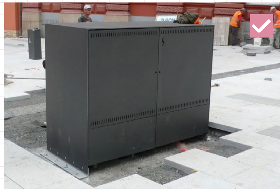
06 Vhodný príklad dizajnového riešenia plechového pláštá integrovanej RIS v antracitovej farbe. Praha
