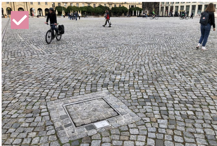
05 Vhodný príklad integrácie a materiálového zjednotenia RIS s povrchom námestia. Drážďany
